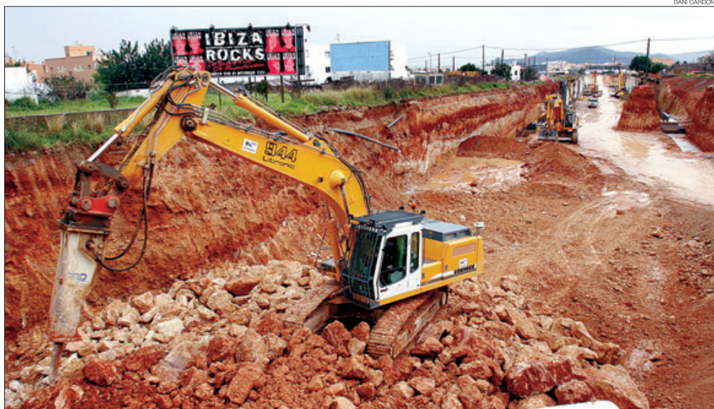
► Diverses excavadores treballen a la rasa oberta per a la construcció del Segon Cinturó, un dels tres trams de l'autovia d'Eivissa.
